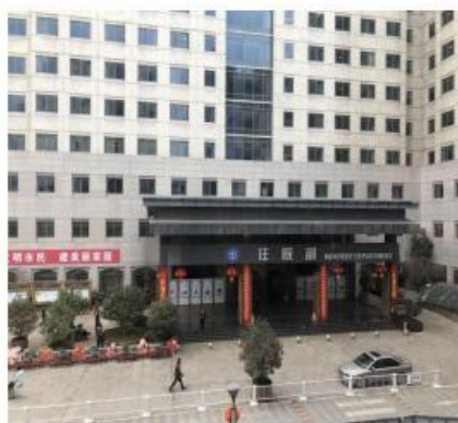
门急诊医技大楼东侧（住院部）
