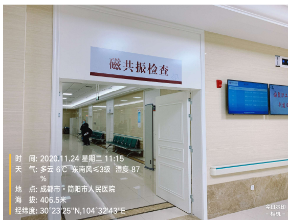
图 8-7 核医学科拟建址东南侧
