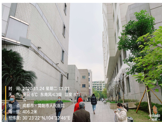
图 8-3 门急诊医技大楼西南侧
