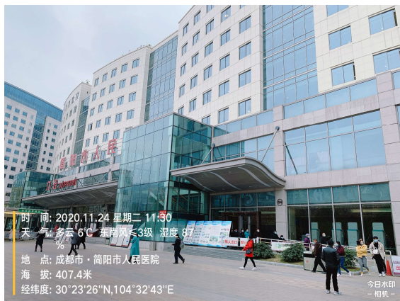
图 8-1 门急诊大楼东北侧
